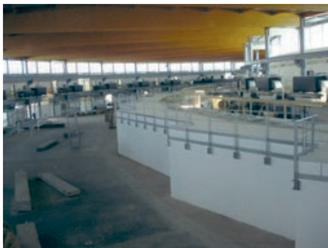
Figure 9 : Hall expérimental en construction du synchrotron SOLEIL (juin 2005). À chaque redent, une ligne de lumière prendra place. Au total, 24 lignes seront ouvertes progressivement entre 2006 et 2010.
