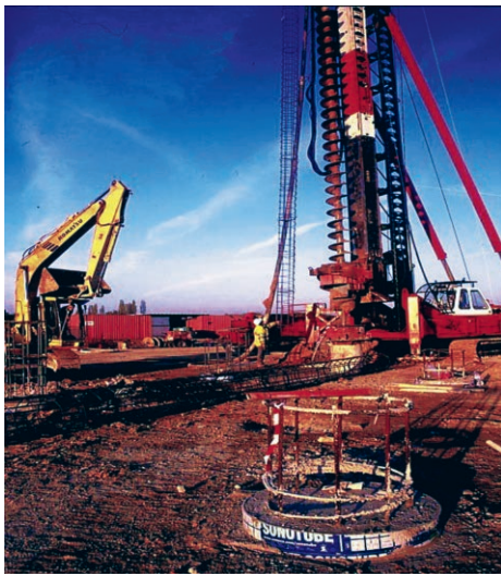
Figure 5 : Installation des pieux pour stabiliser le bâtiment du synchrotron, en octobre 2003.
